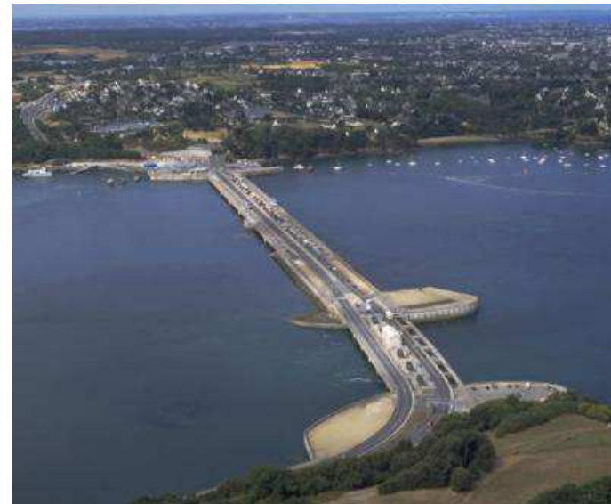
Usine marémotrice de la Rance
